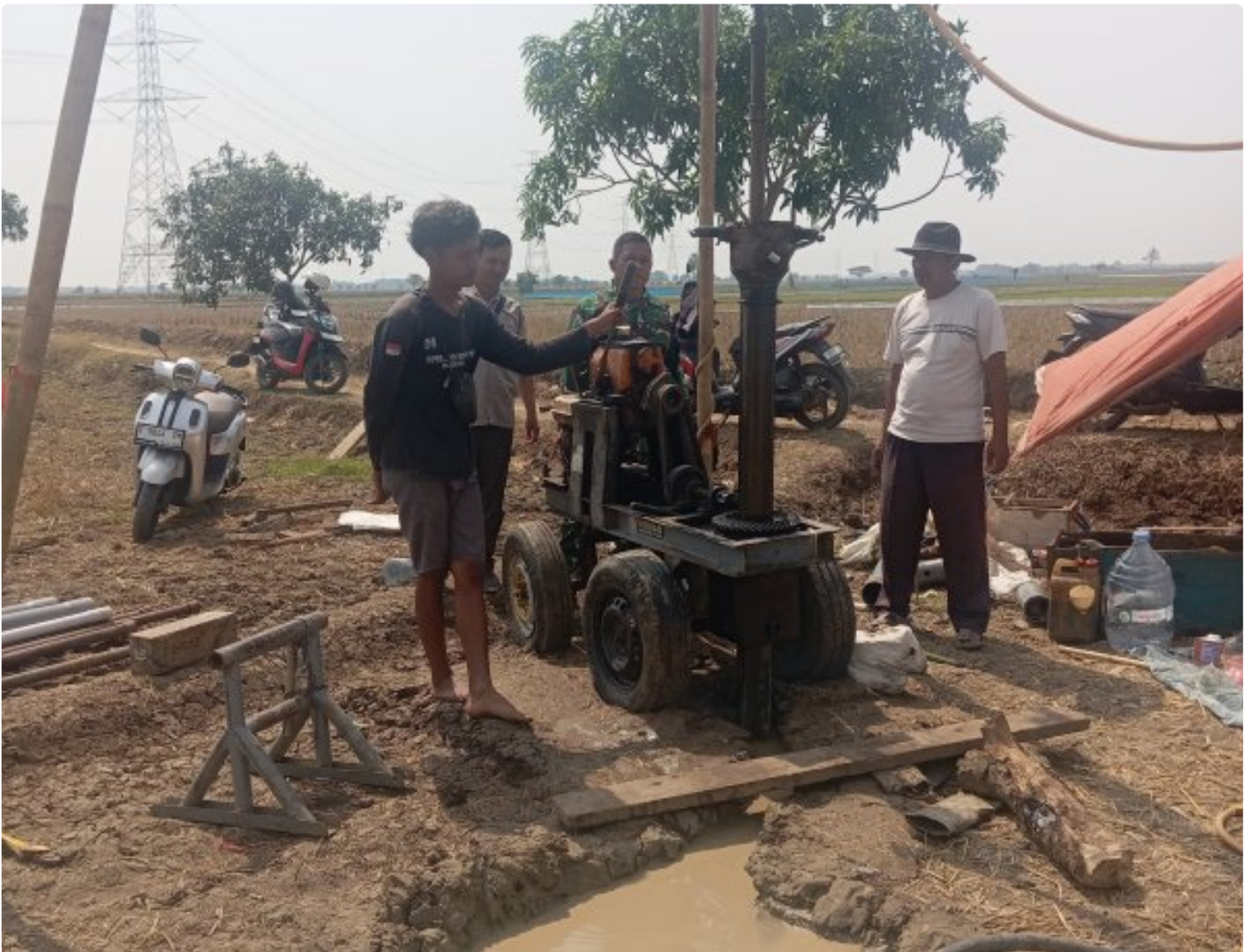
Pertumbuhan Hendra Mukti monitoring pengeboran sumur di Desa Bojong jaya
